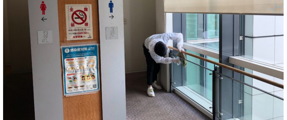
栄養室の光触媒施工の様子
