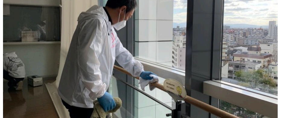
チャイルドスペースの光触媒を施工する様子
