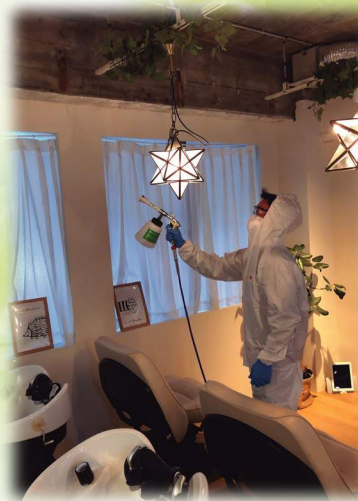
専門技術スタッフによる安心施工
